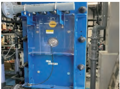
電気透析によって必要イオンを採取
